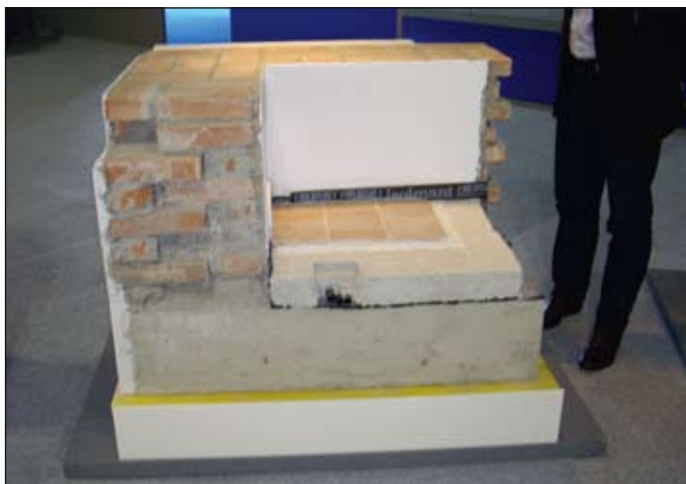
En gammeldags vanlig bygningskonstruksjon i Syd-Europa med svært dårlig isoleringsevne.
