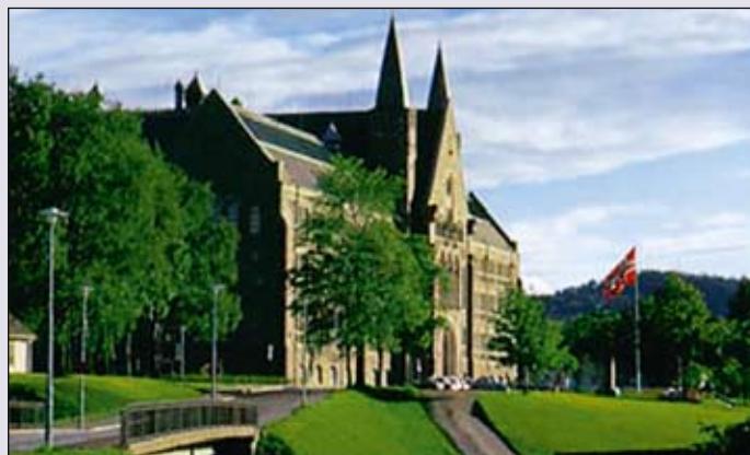
NTHs (nå NTNU) gamle ærverdige hovedbygning på Gløshaugen i Trondheim.
