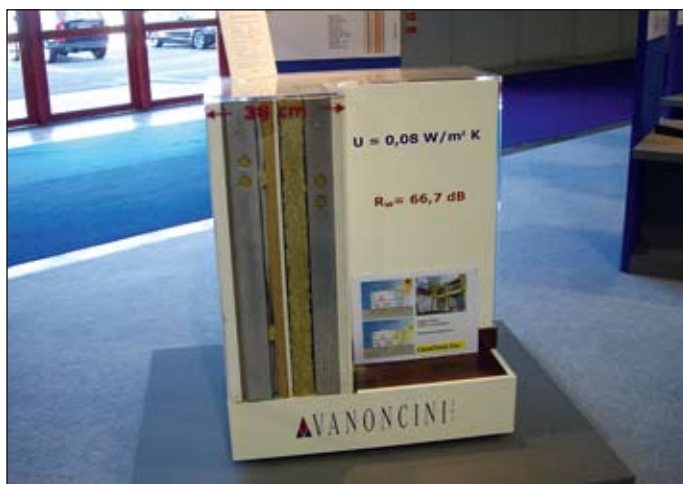
En moderne bygningskonstruksjon med god isoleringsevne, så vel sommer som vinter.
