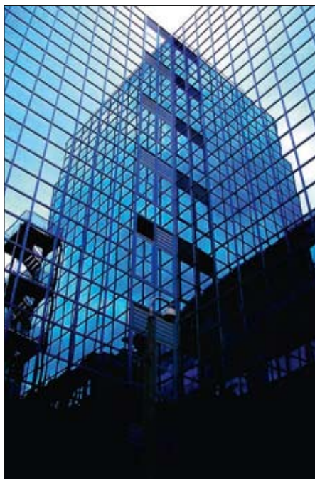
Næringsbygg med store glassfasader og store krav til kjøling ligger utenfor forskriftenes rammer.
