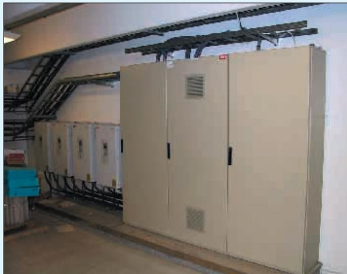
Tavler med frekvensomformere for styring av innfrysningstunneler
