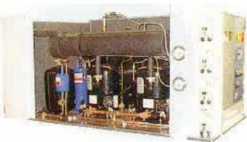
Små og mellomstore kompakt- eller splittaggregater for innendørs eller utendørs montering; eller bare condensing-unit.
