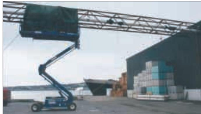
Fordamper og kondensatorledninger av Preisolerte rør mellom gammelt og nytt frysela ger henger i en bro høyt over bakken.
