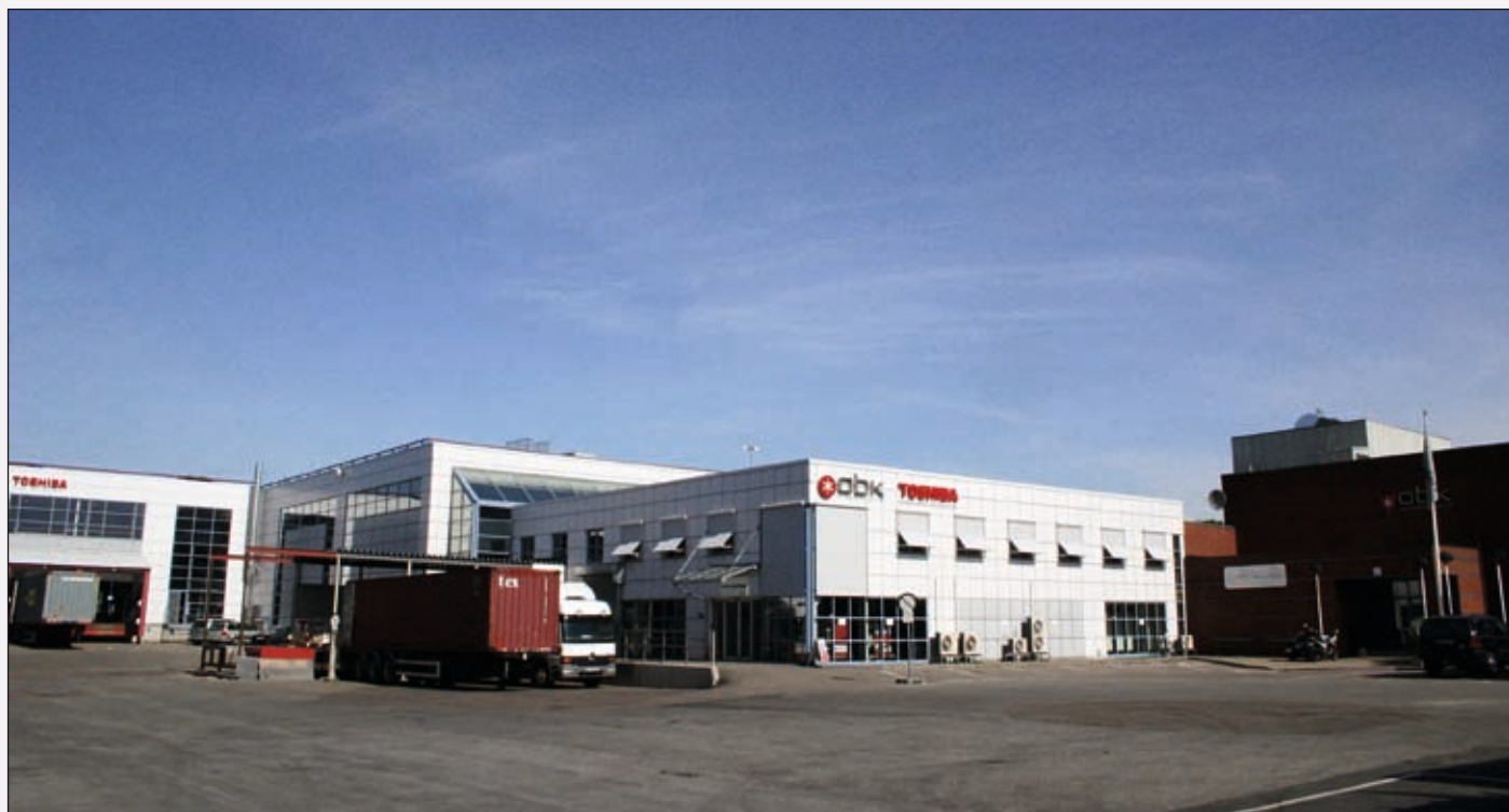
ABKs lokaler utenfor Oslo med tollageret til venstre.
