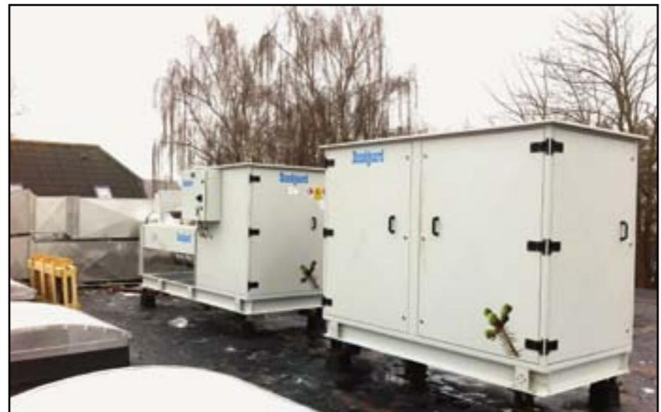
Billedet viser det luftkølede vandkøleanlæg AWC 40-1 og den medfølgende hydrostation H1-200.
