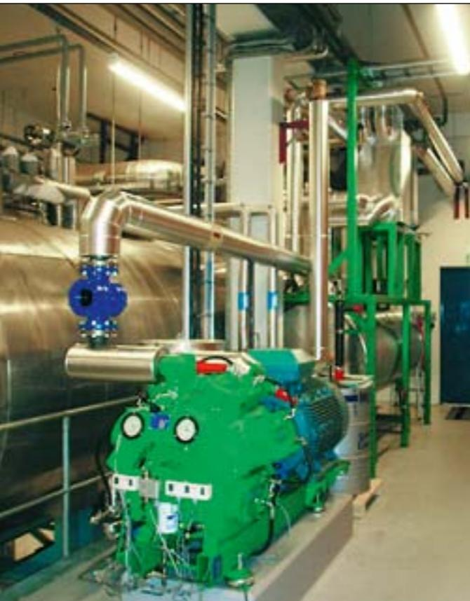
Hybridvarmepumpen på 650 kW udnytter spildvarmen på et slagteri i Nortura-Rudshøgda i Norge. Installationen har været i drift siden 2007. (Foto: Hybrid Energy).
