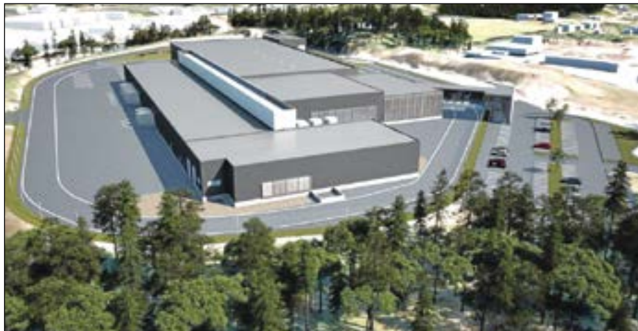
TINEs nye meieri til 800 millioner på Flesland utenfor Bergen blir Nordens mest energieffektive. En varmepumpe vil f.eks. gjenvinne varme fra kjølelageret og produserer damp for bruk i produksjonen.
