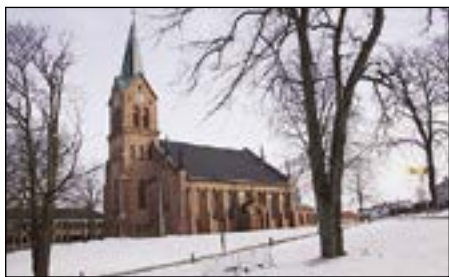
Det blir solcellepaneler på taket av Sarpsborg kirke. Foto: Stig Granås
