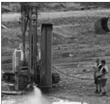
Ved å bore ned rør for å varme berggrunnen med 100 graders vann håper Öresundskraft å kunne lagre overskuddsvarme fra Filbornaverket. Foto: Öresundskraft (tatt tidligere).
