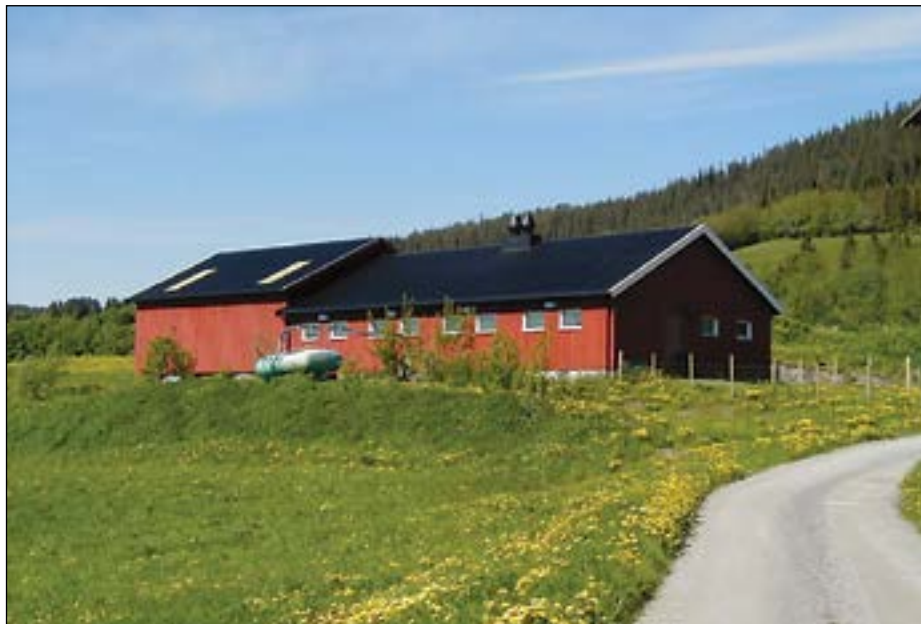
Driftsbygninger i landbruket har fått utsatt fristen for utfasing av oljefyrte anlegg fra 1.1 2020 til 1.1 2025.
