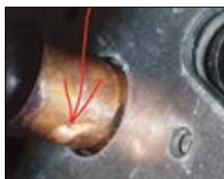
27 Frostsprengning ved mangelfull CO 2 vakuumering
