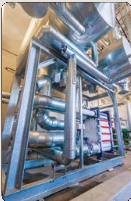
Pladevarmeveksleren er lagt ud for tækspansion. Denne har en kølekapacitet på ca. 400 kW. Anlægget køler et frysehus/kødforbehandlingsanlæg med et samlet volumen på 64,000 m 3 .
